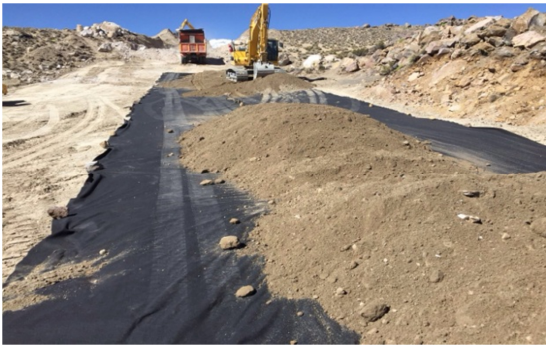
Foto 4: Colocación de terraplén sobre el geotextil.
