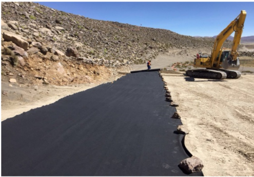
Foto 3: Instalación del geotextil, posterior al enrocado.
